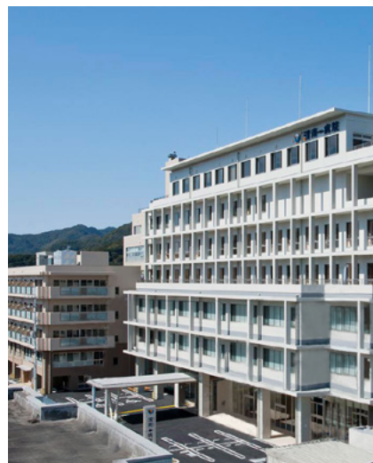
ゆうわ渭南(写真奥)と隣接する渭南病院／ 目の前には薬局もあり、処方箋調剤が必要な方は ご利用に便利な環境となっています。
